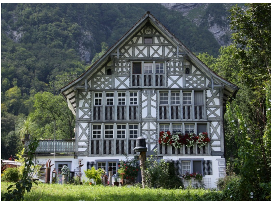
Stählihaus in Netstal: Ansicht Giebelseite – Blickrichtung West.
